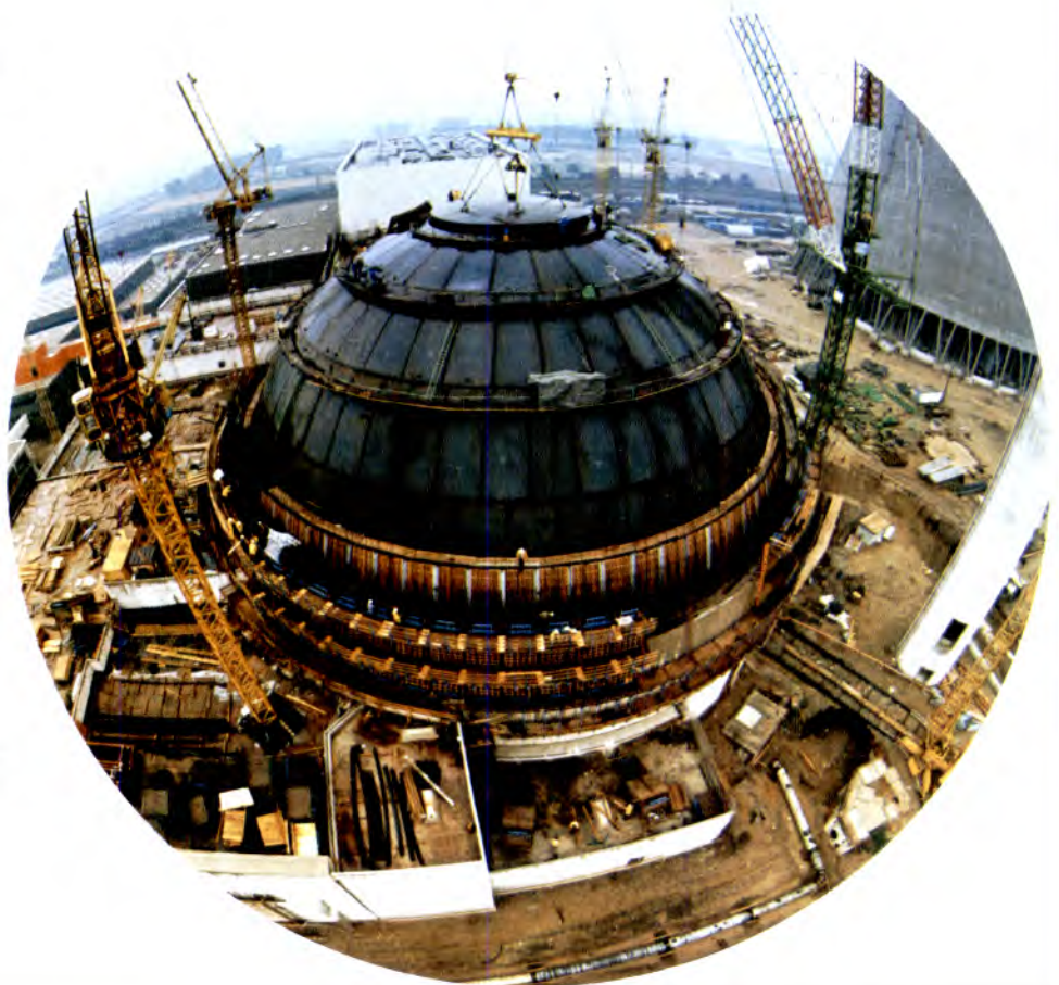
Bild 42: Schließen des Sicherheitsbehälters Mülheim-Kärlich
