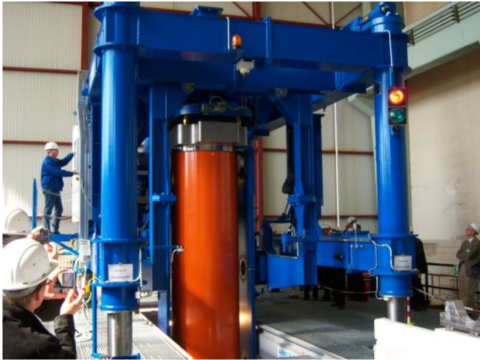
Abb. 5.12 Abschirmhaube setzt auf den Transferbehälter auf
