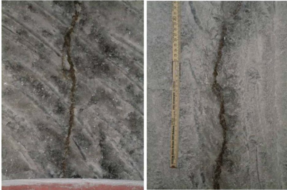
Abb. 2.1 Ausbildung der von /BAU 91/ als „kryogene Klüfte“ bezeichneten Rissbildungen im Salzstock Bokeloh (Kalisalzbergwerk Sigmundshall, 350 m-Sohle)
