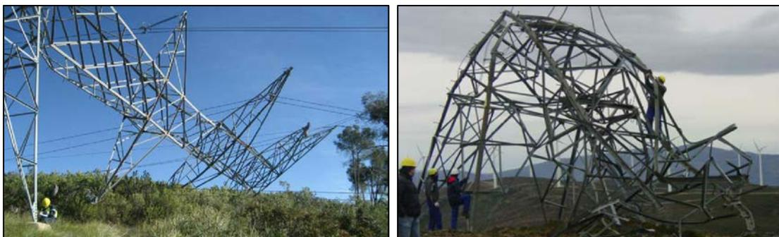
**Abb. 3.23** Durch Orkan „Klaus“ verursachte Schäden an Strommasten in Nordspanien [146]
