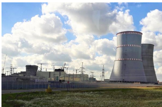
Bild 5: Baustelle des weißrussischen KKW Ostrovets im September 2018 (Quelle: GRS).
