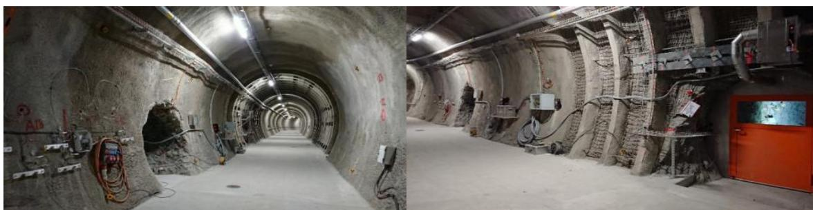
**Bild 16:** Sicht in den Tunnel. Links: Eingang zur offenen Nische; Rechts: Eingang zur geschlossenen Nische
