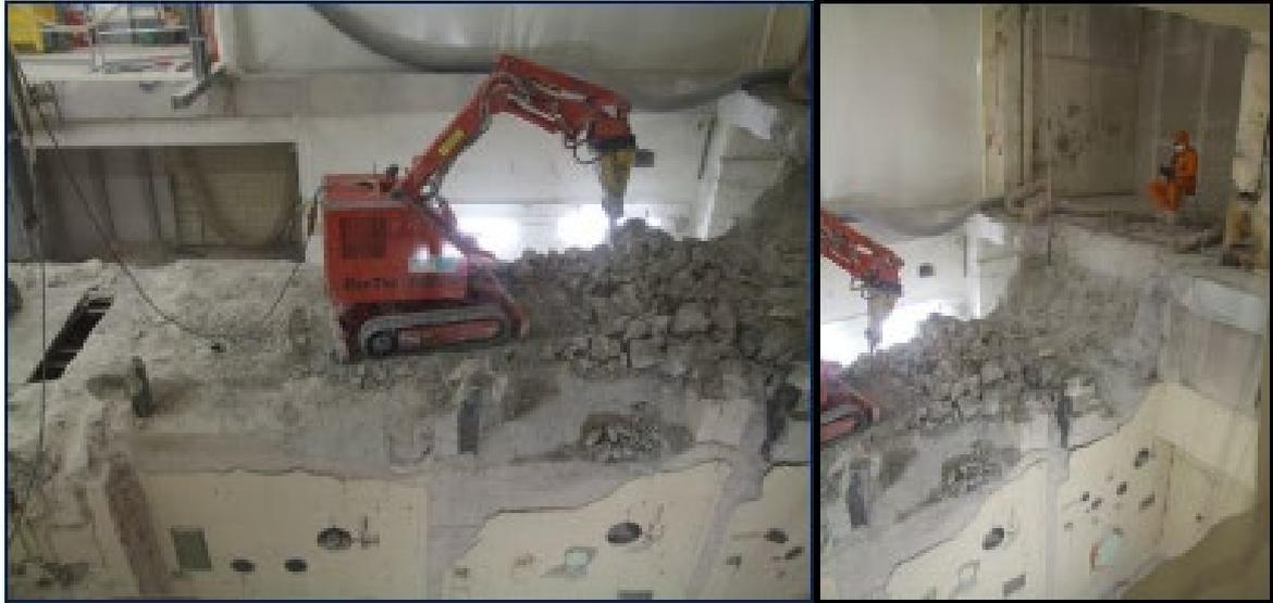
**Abb. 2.73** (linkes Bild) ferngesteuerter, elektrohydraulischer Kleinbagger auf einer Stampfbetonwand der Heißen Kammern, (rechtes Bild) Bediener in sicherer Entfernung
