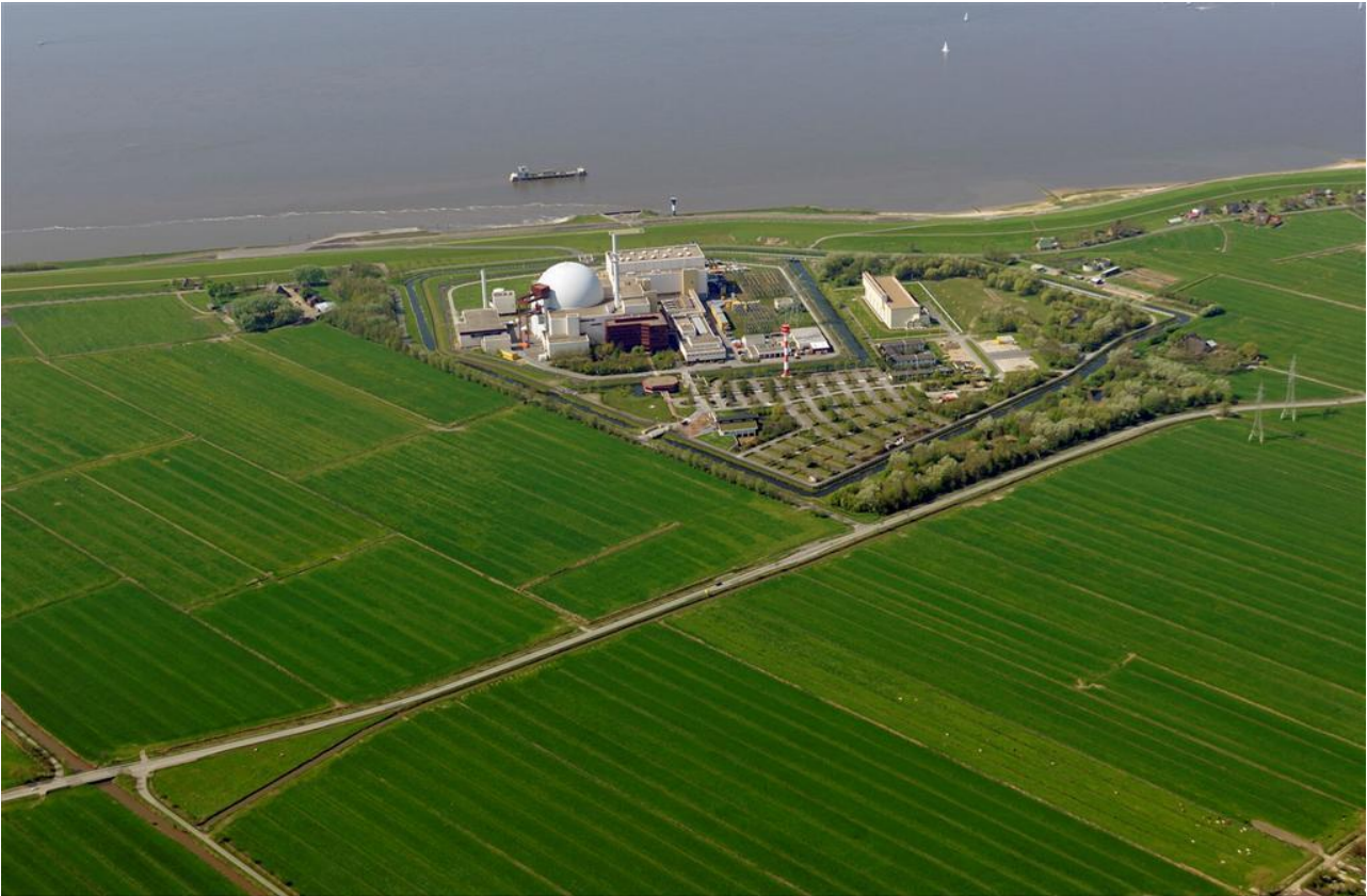
Abbildung 7-4: Das Atomkraftwerk Brokdorf an der Elbe
