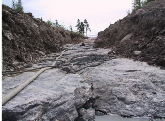
Trenching (2D Kartierung von (Diskontinuitäten))
