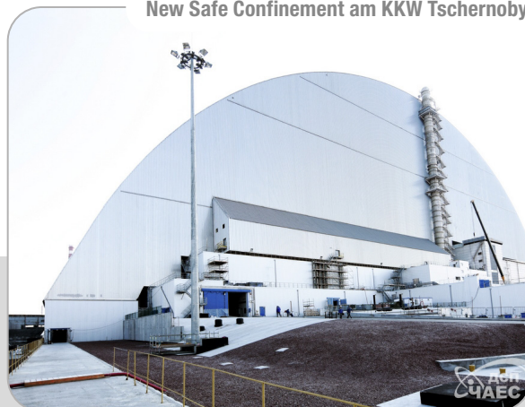
New Safe Confinement am KKW Tschernobyl
