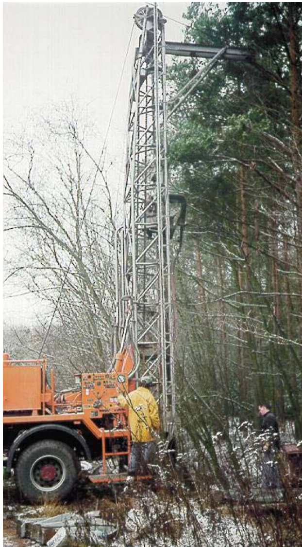
Abb. 3.1.4: Bohrarbeiten am Standort Heselbach; hier: Bohrung B2
