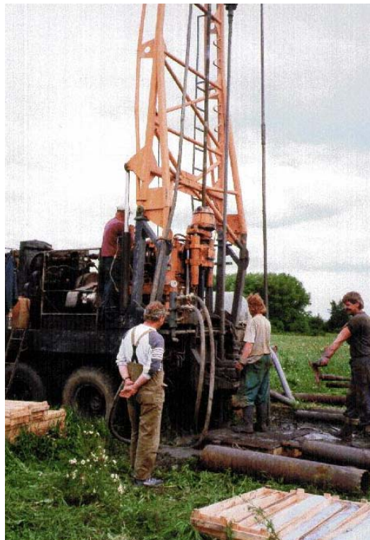
Abb. 2.1.6: Bohrarbeiten zur Bohrung NA4
