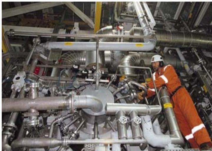
**Abb. 2.10** Teil der Obertageanlage für die CO<sub>2</sub> Injektion
