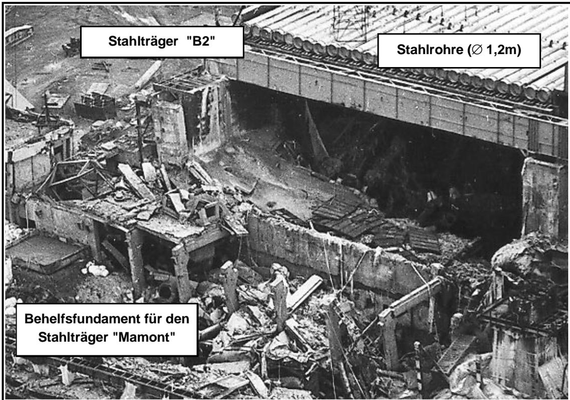
**Bild 4-3** Zerstörter Block 4: Während der Konstruktionsphase des Sarkophags
