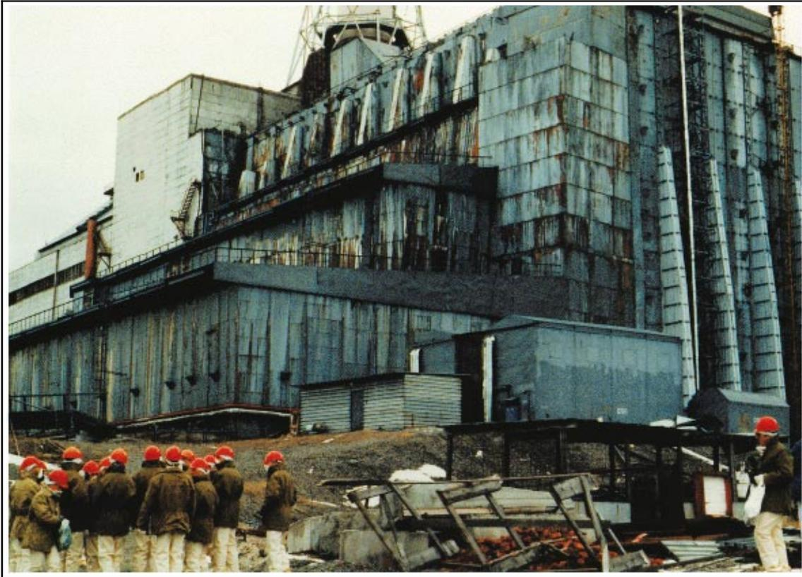
**Bild 4-5** Arbeitsbesprechung beim im Bau schon weit fortgeschrittenen Sarkophag; rechts die Stahlhohlwand mit Strebepfeilern
