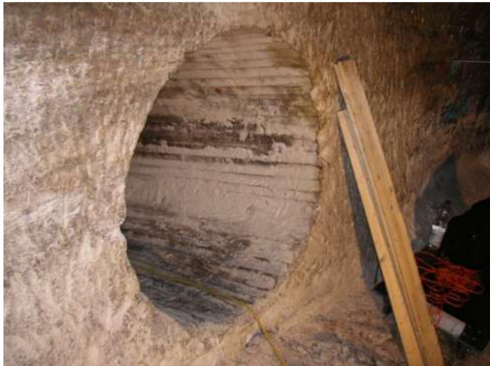
**Abb. 7.21** Bauphase – Erstellung des Bohrlochs
