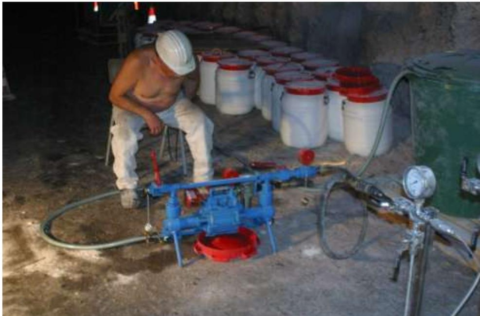
**Abb. 7.18** Flutung des Großbohrlochs mit Tachydrit-Lösung
