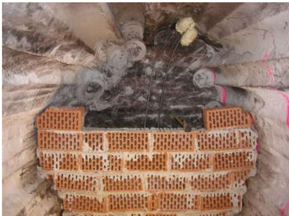
**Abb. 7.22** Bauphase – Flutungskammer mit Flutungsleitungen, Kiesschüttung und Lochsteinmauer
