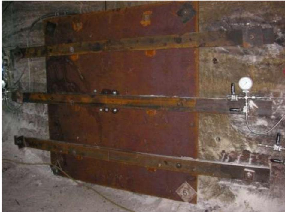
**Abb. 7.29** Bauphase – Anbringen der Sicherheits- Stahlplatte
