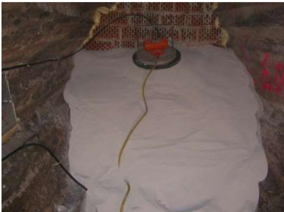
**Abb. 7.26** Bauphase – Einbau und Verdichten von Magnesiumsulfat
