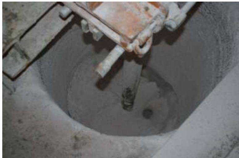
**Abb. 7.13** Erstellung des vertikalen Großbohrlochs im Carnallit in der Asse
