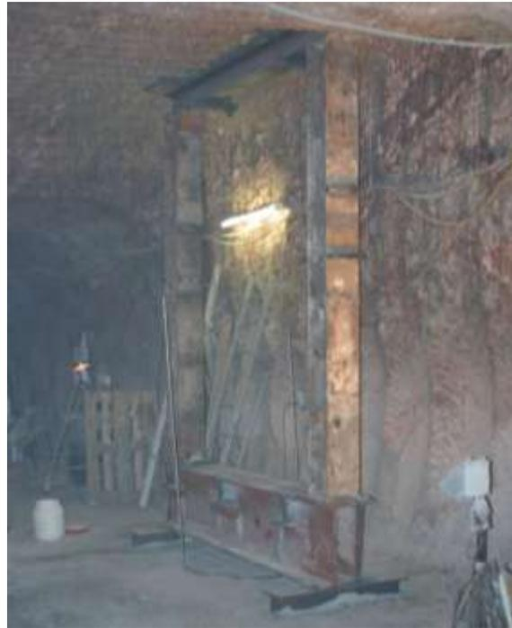
**Abb. 7.15** Stahlkonstruktion für die Abstützung des Betonstopfens
