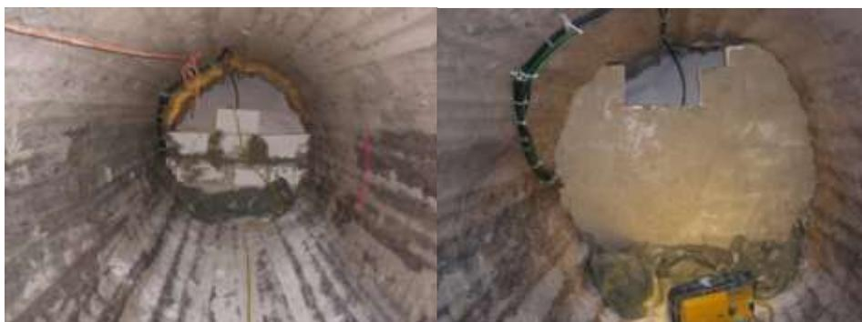
**Abb. 7.27** Bauphase – Trennmauer zwischen Magnesiumsulfat und Widerlager
