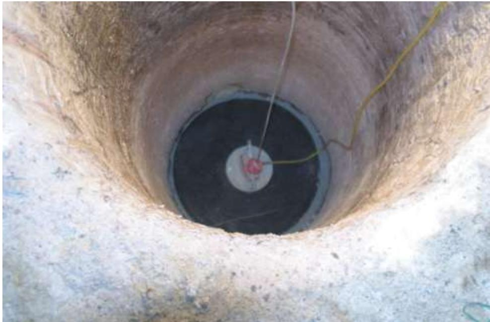
**Abb. 7.14** Rüttler für die Verdichtung des SVV im Bohrloch
