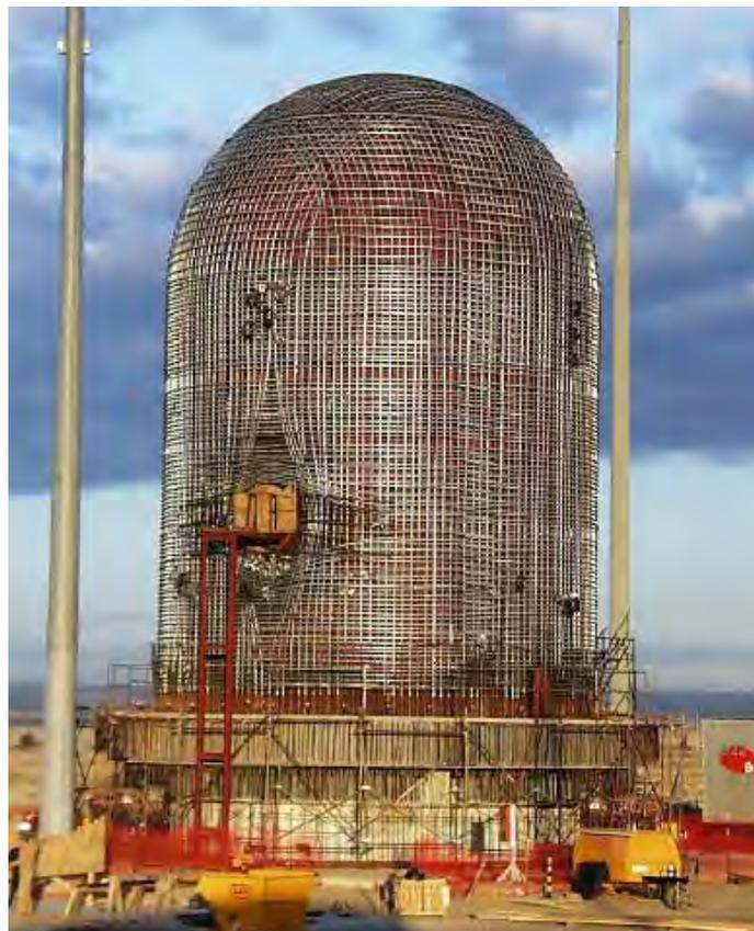
**Abb. 5-6** Anordnung der Führungsrohre für die Spannkabel, Aufnahme während der Errichtung (aus /HES 03/)
