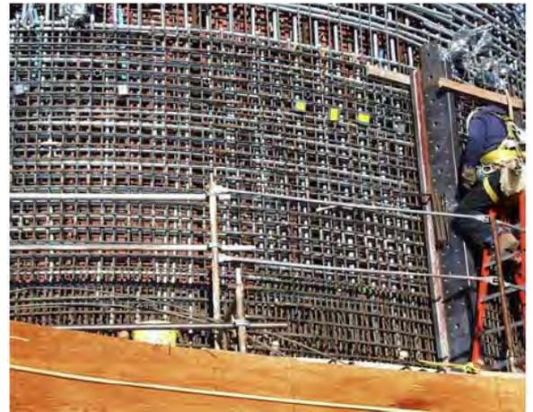
**Abb. 5-7** Innere und äußere Bewehrung im SANDIA-Modellcontainment (aus /HES 03/)
