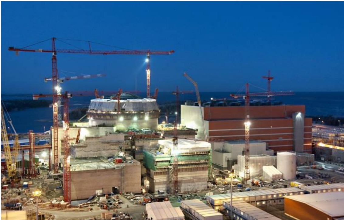
Abb. 4.1 Blick auf die Baustelle des KKW Olkiluoto, Block 3 (Sommer 2010)
