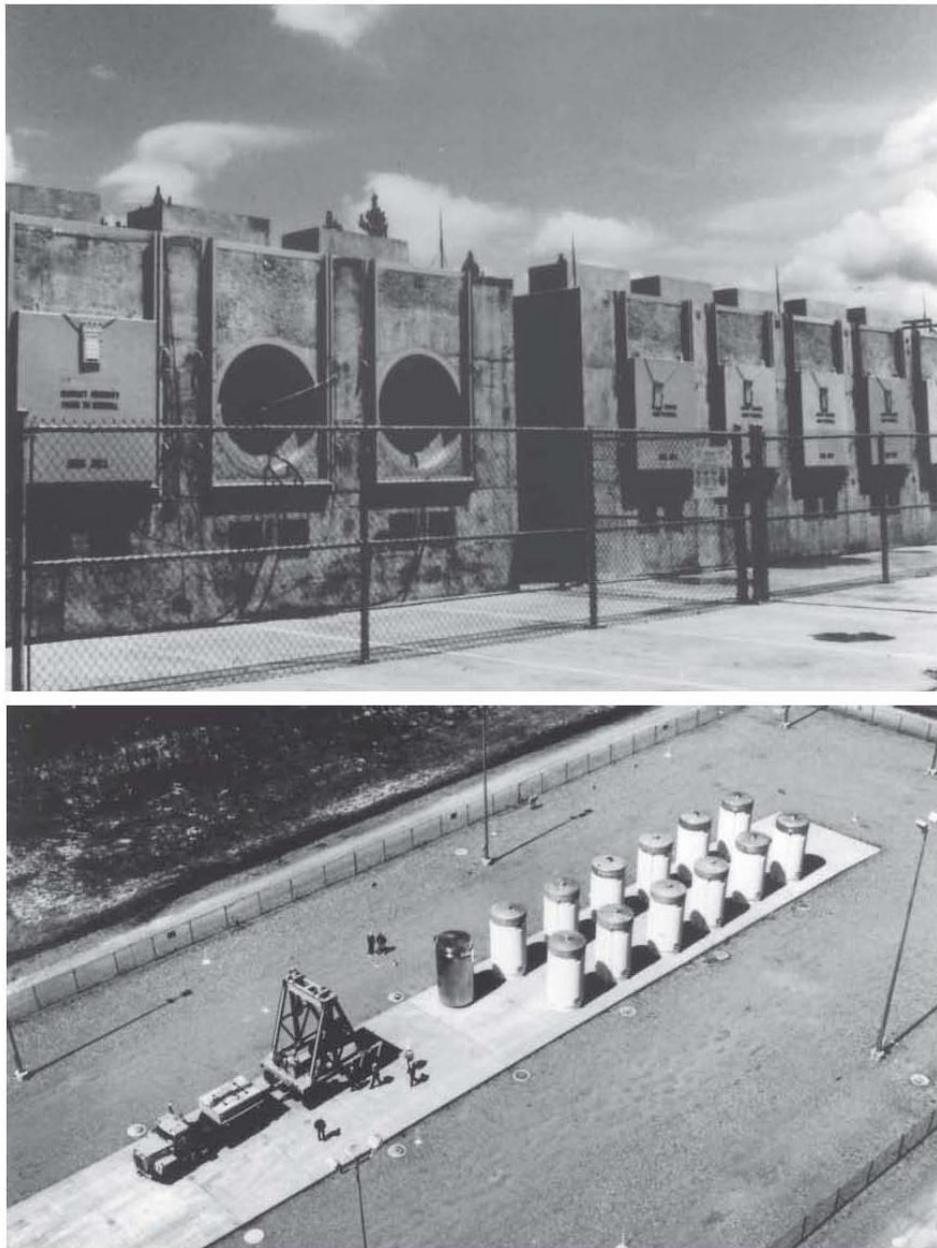
**Abbildung 2-16:** Zwischenlagerung von Trockenlagerbehältern in USA (oben: Robinson; unten: Surry) /NRC 02/
