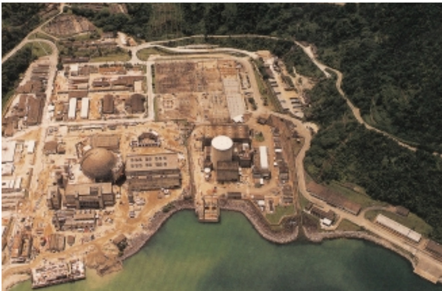
Kernkraftwerk Angra in Brasilien, Block 2 links im Bild Angra NPP in Brasil, Unit 2 on the left
