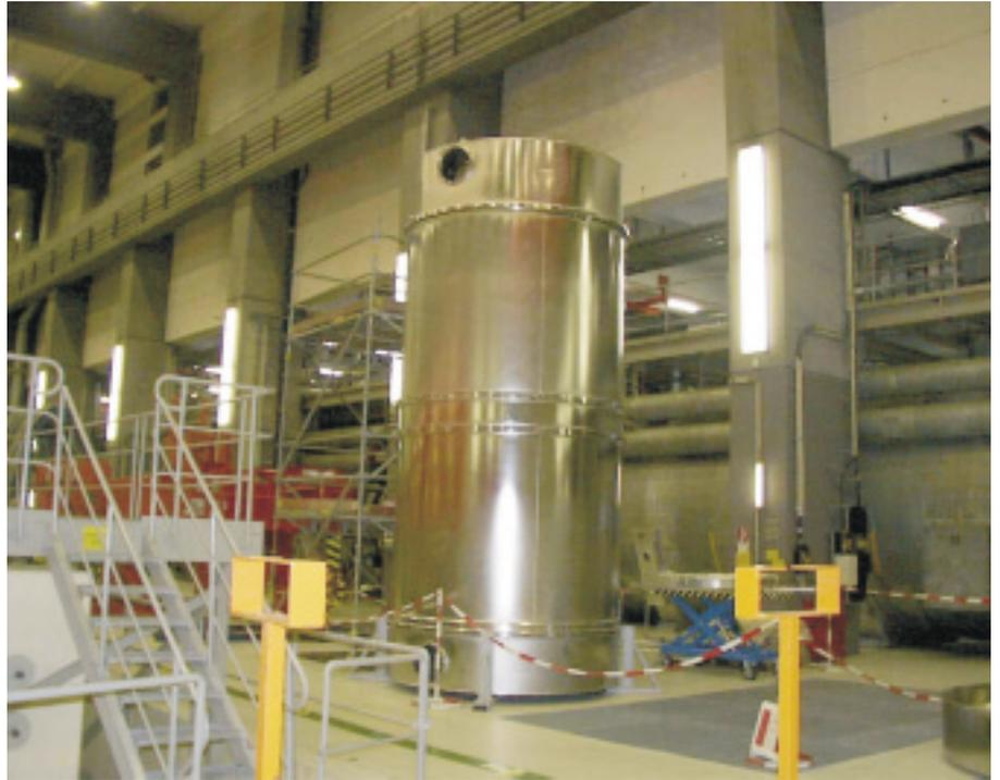
▲ Eine der Verbesserungsmaßnahmen zur Vorbeugung von radioaktiven Verunreinigungen bei der Be- und Entladung von Transportbehältern für abgebrannte Brennelemente ist ein sogenanntes Kontaminationsschutzhemd. Das Foto zeigt ein solches aus Metall im Kernkraftwerk Biblis.
