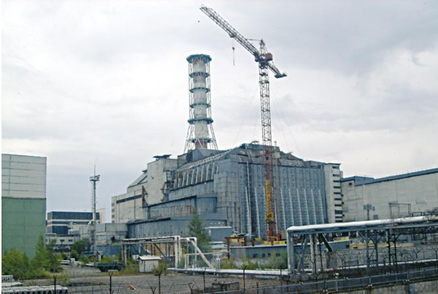
▲ Objekt „Shelter“ in Tschernobyl
