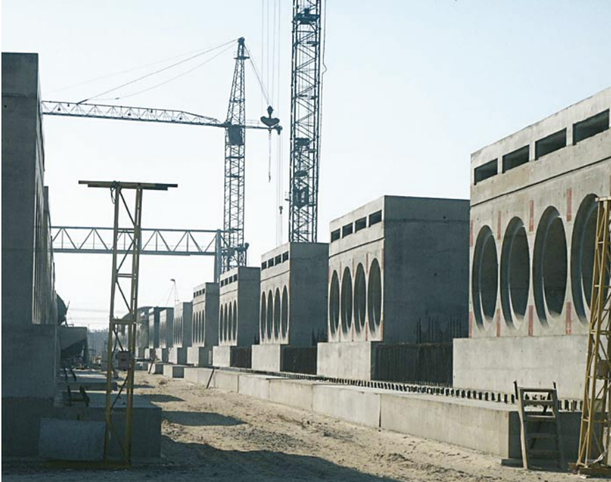
▲ Ansicht des in Bau befindlichen Trockenlagers ISF-2 für abgebrannte Brennelemente aus den stillgelegten Reaktoren vom Typ RBMK in Tschernobyl
