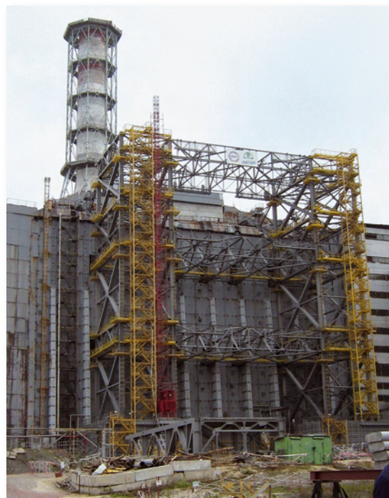
▲ Ukraine – KKW Tschernobyl, Block 4: Laufende Stabilisierungsmaßnahmen am Sarkophag – Teilaufgabe Stabilisierung der Westwand Ukraine – Chernobyl NPP, Unit 4: On-going measures to stabilise the Sarcophagus – Subtask “Stabilising the West Wall”
