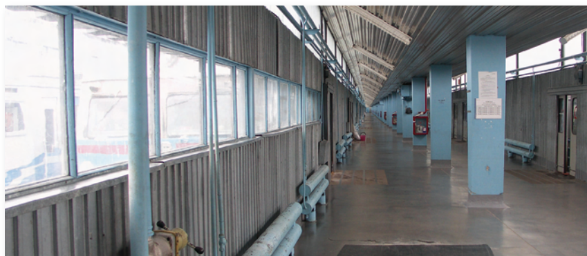
▲ Bahnhof in Tschernobyl. Der Bahnsteig ist zur Zugseite geschlossen und verfügt über Türöffnungen, deren Positionen mit den Waggontüren übereinstimmen. Dadurch werden Kontaminationen im Bahnhof- und Zuginneren vermieden. Chernobyl train station. There is a wall on the platform on the side where the trains stop, with openings giving access to the carriage doors. This way, any contamination on the trains is prevented from spreading into the station and the carriages.
