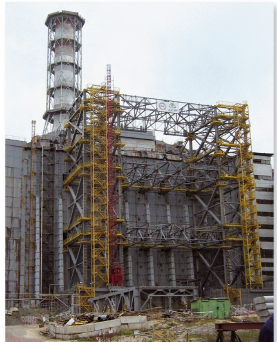
▲ Ukraine – KKW Tschernobyl, Block 4: Laufende Stabilisierungsmaßnahmen am Sarkophag – Teilaufgabe Stabilisierung der Westwand Ukraine – Chernobyl NPP, Unit 4: On-going measures to stabilise the Sarcophagus – Subtask “Stabilising the West Wall”
