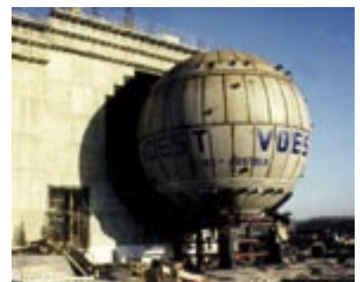
Einfahren des Sicherheitsbehälters in das Reaktorgebäude
