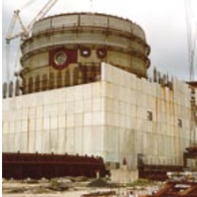
Fast fertiggestelltes zylindrisches Containment mit dem umgebenden Reaktorgebäude des Kernkraftwerks Stendal Anfang 1991
