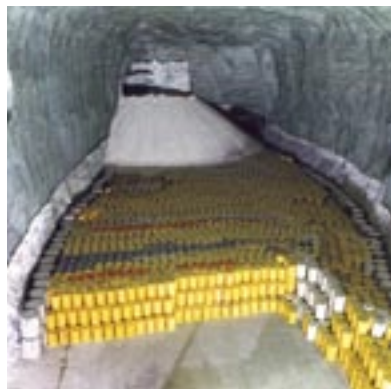
Fässer mit radioaktivem Abfall im Endlager Morsleben
