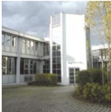
Im Oktober 1989 wird der zweite GRS-eigene Neubau auf dem Forschungsgelände Garching fertiggestellt
