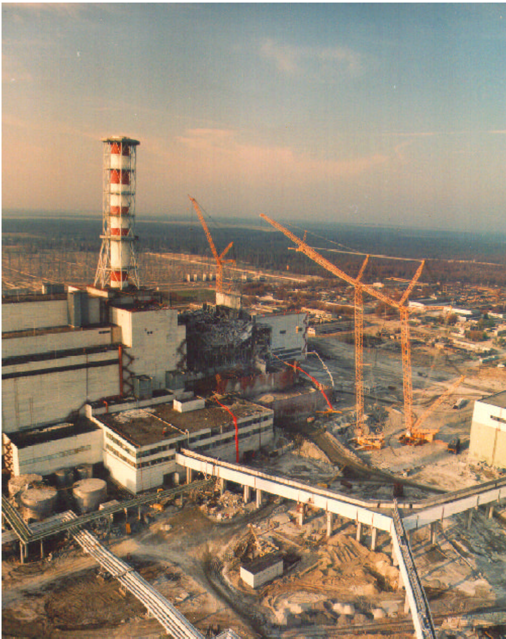
Bauarbeiten zur Errichtung des Sarkophags nach dem Unfall am 26. April 1986
