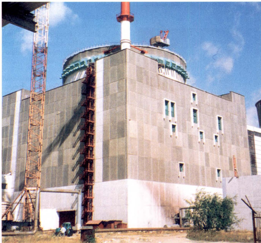
Bild 4.10: Reaktorbau mit Containment des Blockes 4 mit WWER-1000
