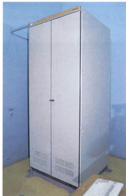
Bild 4.14: Der Primärkreis an den Blöcken 1 bis 4 wurde mit Lecküberwachungssystemen (ALÜS) nachgerüstet.
