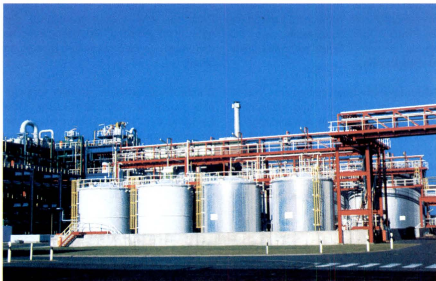
Die Tanklagerung brennbarer Flüssigkeiten, die den strengen Anforderungen der BImSchV unterliegt, ist einer der Themenschwerpunkte des TAA (Bild: Bayer AG)
