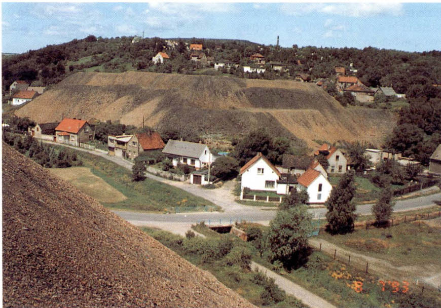
Bild 7.6: Halden in dicht besiedeltem Wohngebiet
