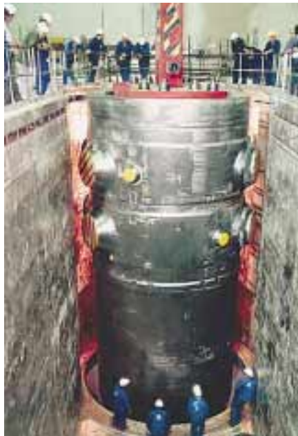
▲ Einbau des Reaktordruckbehälters Installation of the reactor pressure vessel
