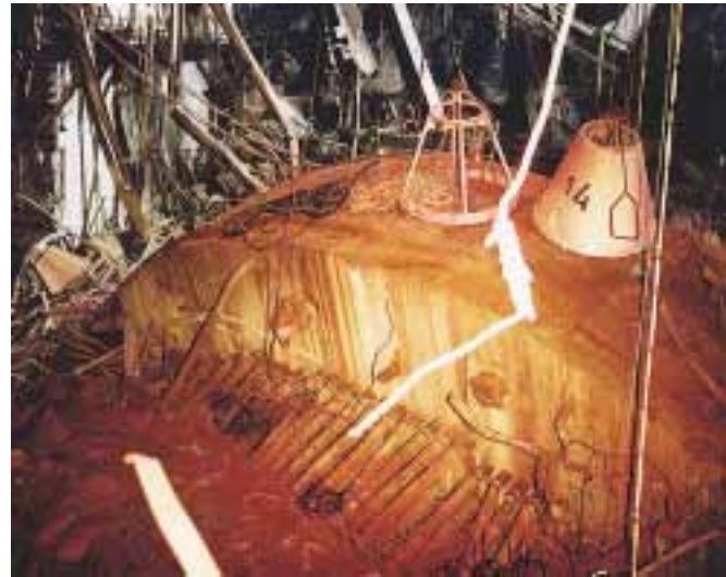
▲ Obere Kernplatte des Reaktors
