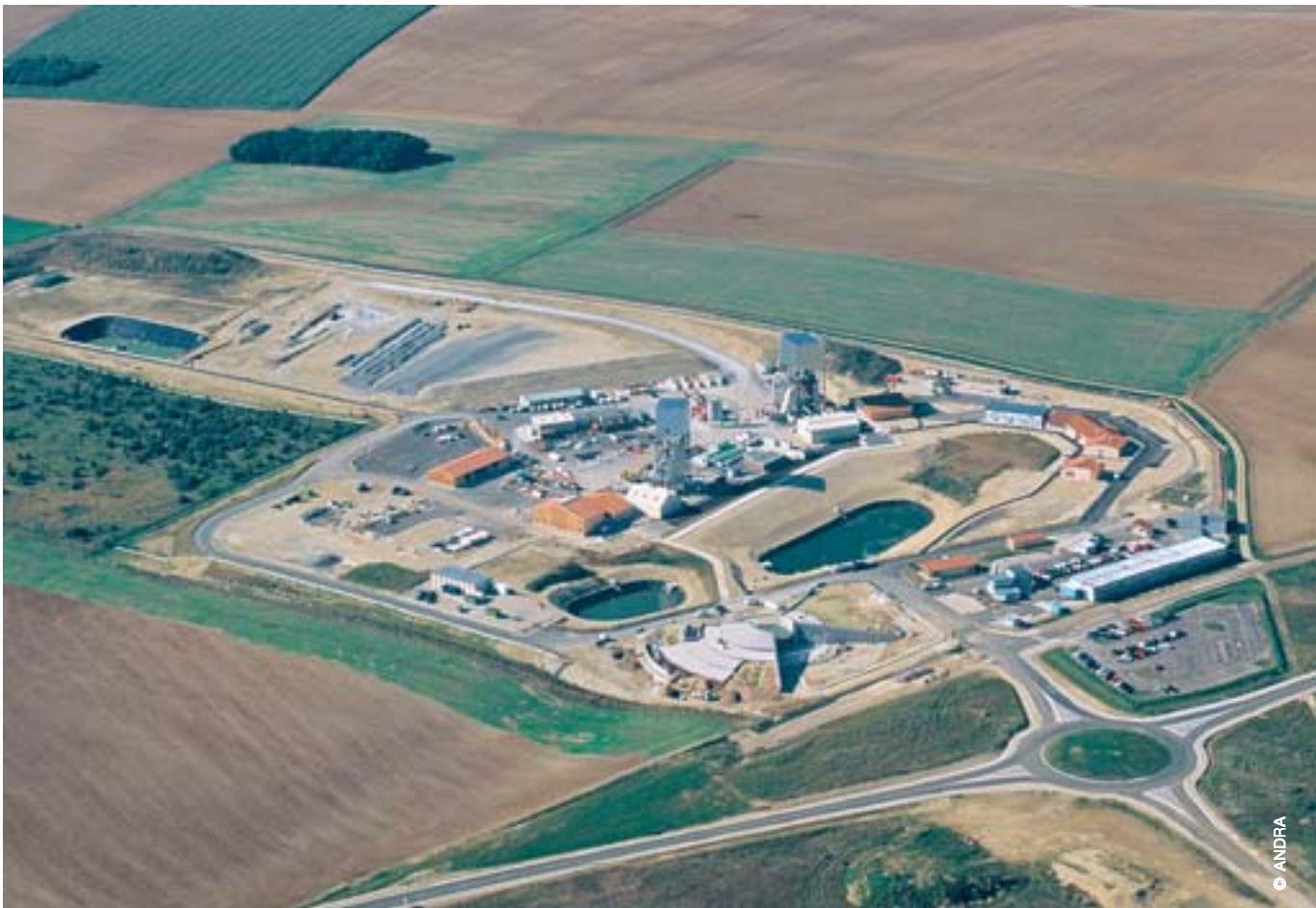
▲ Errichtung eines URL am Standort Bure Construction of a URL at the Bure site
