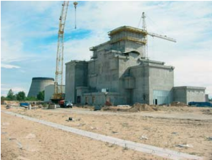
▲ Baufortschritt des Zwischenlagers für abgebrannte Brennelemente (ISF-2) im September 2003 Construction progress on the interim storage facility for spent fuel (ISF-2) in September 2003
