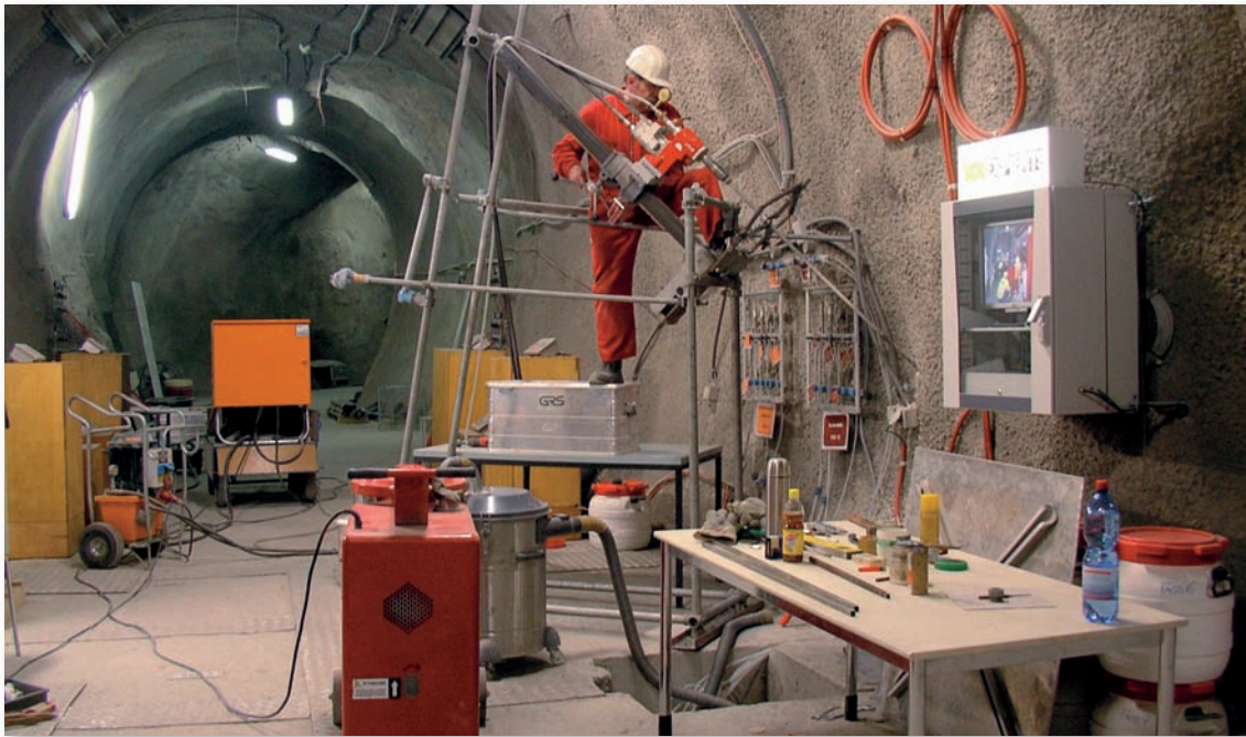
◀ Erstellen eines Messbohrloches für Gasinjektionstests (HG-C/BET) im Untertage Labor Mont-Terri. Construction of a measurement borehole for gas injection tests (HG-C/BET) in the underground laboratory Mont-Terri.
