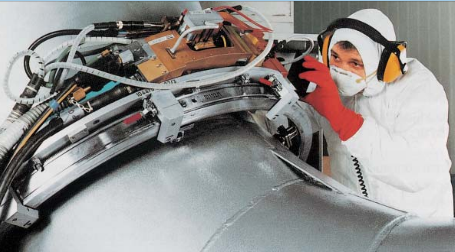
Schweißarbeiten an einem Rohr
