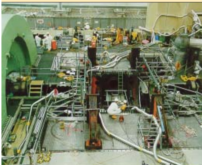
Arbeiten an der Niederdruck-Turbine im Kernkraftwerk Philippsburg 1
