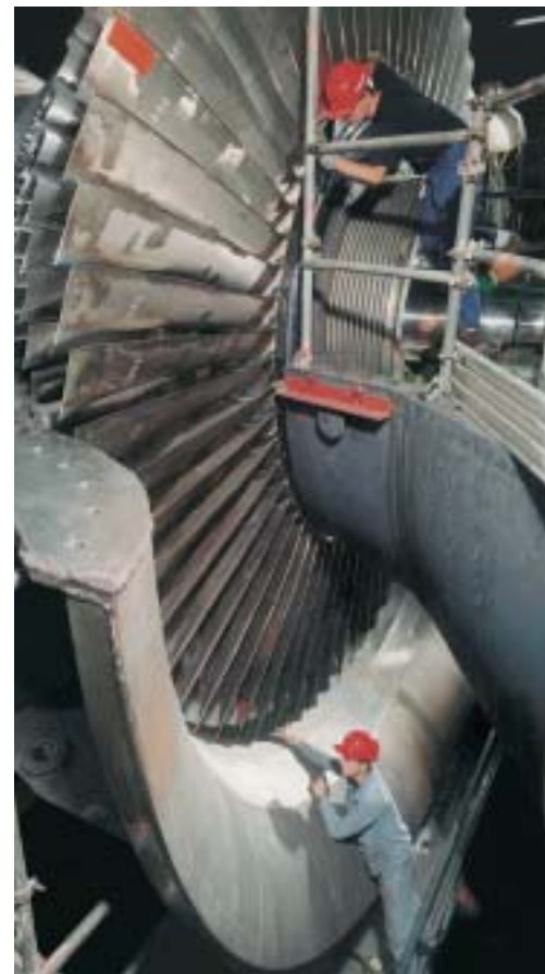
Durch den Einbau neuer Schaufelreihen wurde in mehreren Kernkraftwerken der Wirkungsgrad der Turbinen erhöht.
