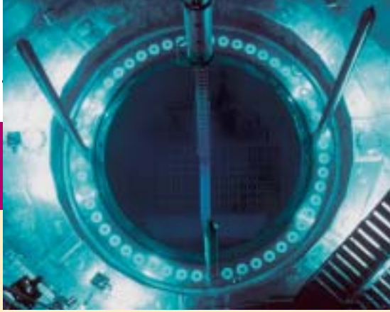
Kernkraftwerk Grafenrheinfeld: Der Reaktor-druckbehälter aus der Vogelperspektive während des Brennelementwechsels
