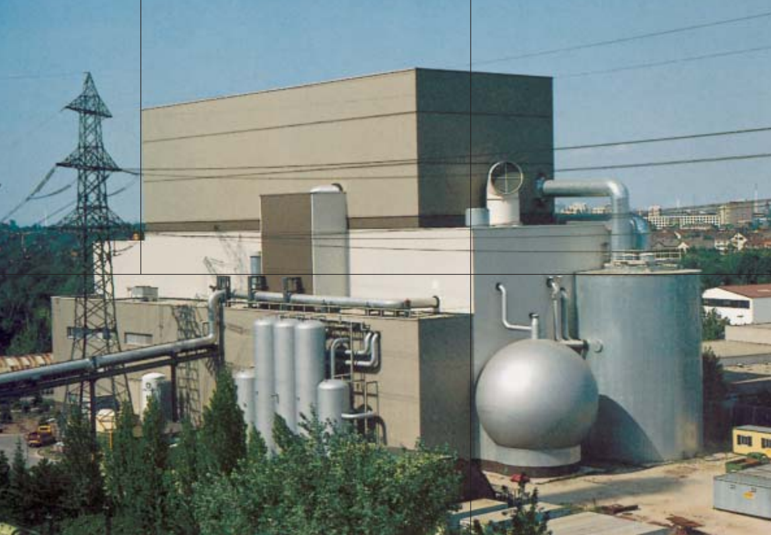
Außenansicht der größten Versuchsanlage der Welt in Mannheim: Hier wurden Störfälle im Kühlsystem eines Druckwasserreaktors simuliert.
