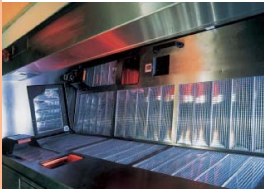
Kernkraftwerk Neckar: Endmonitor für die kontrollierte Ableitung radioaktiver Stoffe
