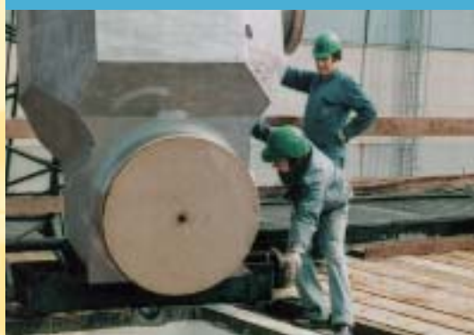
Einbau einer Armatur
