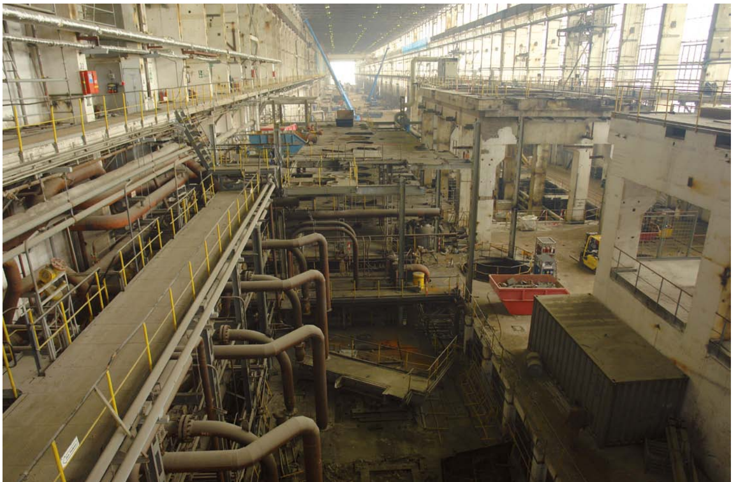
Abb. 41: Maschinenhaus des Kernkraftwerks Greifswald nach der Entfernung der Generatoren
