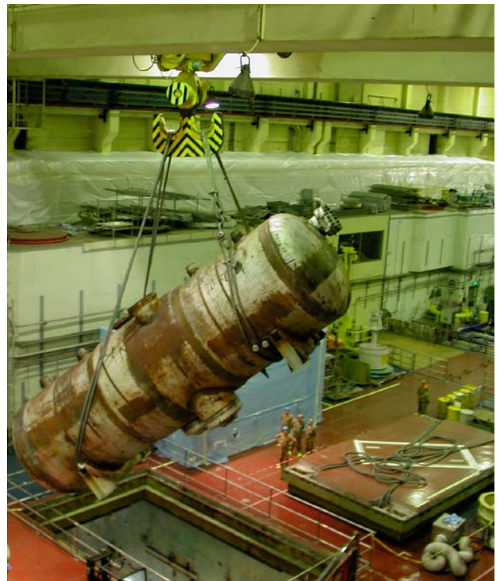
Abb. 10: Demontage eines Dampferzeugers im Rahmen des direkten Abbaus
