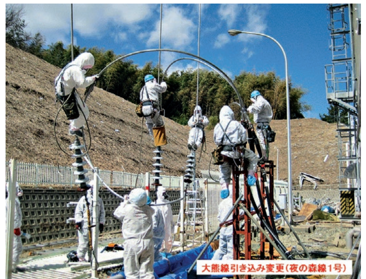
Abb. 6.4: Arbeiten zur Wiederherstellung der Anbindung der Anlage an das Stromnetz (Quelle: TEPCO).
