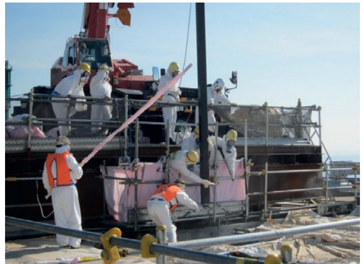
Abb. 6.19: Bergen zweier unbestrahlter Brennelemente aus dem BE-Lagerbecken von Block 4 (Quelle: TEPCO).
