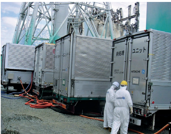
Abb. 6.3: Mobile Anlagen zur Entsalzung des Wassers in den BE-Lagerbecken (Quelle: TEPCO).
