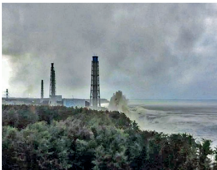
Abb. 3.2: Von einer Überwachungskamera aufgenommenes Bild einer Tsunami-Welle (Bildmitte, rechts neben dem Abgaskamin), die sich beim Auftreffen auf den Standort auftürmt. Zwischen den beiden Abgaskaminen ist der obere Teil des Reaktor Gebäudes von Block 4 mit einer Höhe von über 40 Metern erkennbar (Quelle: TEPCO).
