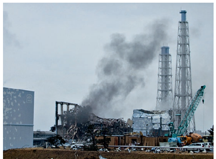
Abb. 3.24: Dunkler Rauch steigt aus dem zerstörten Reaktorgebäude 3 auf (Quelle: TEPCO).
