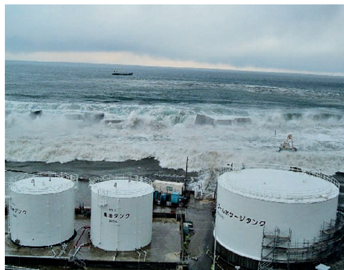
Abb. 3.3: Beginn der Überflutung des Anlagengeländes, aufgenommen von einer Überwachungskamera. Aus späteren Luft- und Satellitenaufnahmen wurde ersichtlich, dass einige Tanks (in diesem Fall zwei Dieselvorrattanks und ein Kühlwasserbehälter) von der Art der hier gezeigten durch den Tsunami zerstört bzw. von ihrem ursprünglichen Standort weggerissen und landeinwärts getragen wurden (Quelle: TEPCO).
