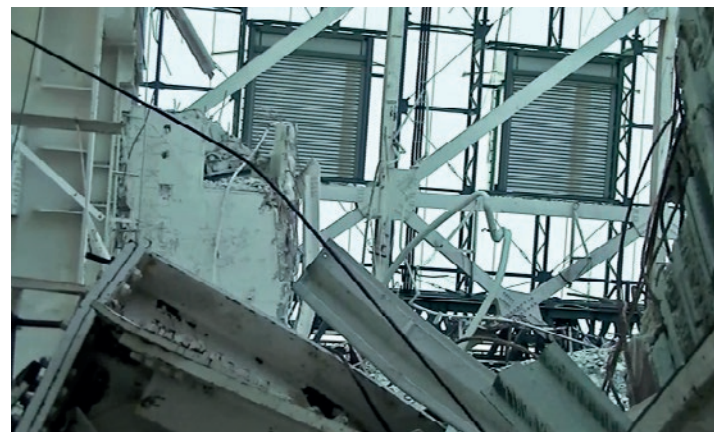
Abb. 6.16: Blick durch den Bedienflur (Quelle: TEPCO).
