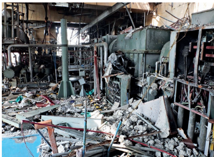
Abb. 3.31: Zerstörungen auf der vierten Ebene in Block 4 (Quelle: TEPCO).
