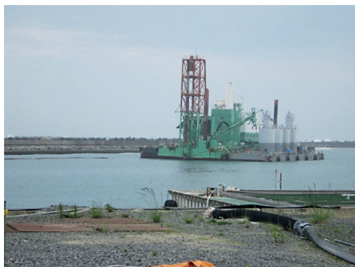
Abb. 6.13: Schwimmendes Arbeitsgerät zur Versiegelung des Meeresbodens (Quelle: TEPCO).
