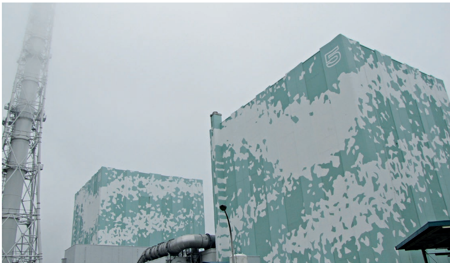
Abb. 3.33: Die nicht zerstörten Blöcke 5 und 6 im September 2011 (Quelle: TEPCO).
