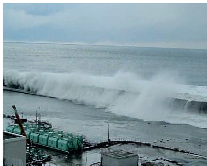
Abb. 3.12: Überflutung des seeseitigen Teils des Anlagengeländes durch erste Tsunamiwellen, aufgenommen durch eine Überwachungskamera (Quelle: TEPCO).
