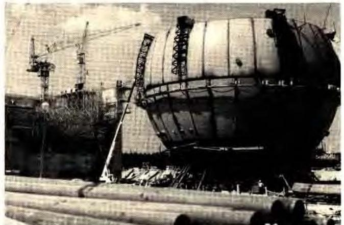
Bild 12: Sicherheitsbehälter Philippsburg in der Bauphase
