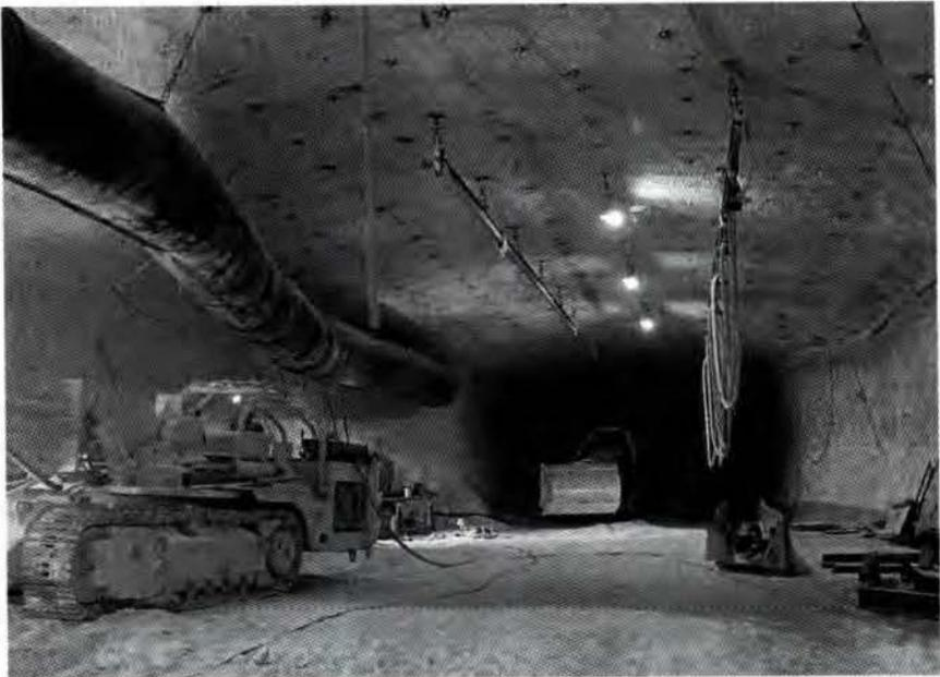
Um den Salzstock Gorleben auf seine Eignung als Endlager für hochaktive Abfälle hin zu untersuchen, muß ein komplettes Bergwerk aufgeföhren werden. Derzeit laufen die Arbeiten zur Errichtung eines Füllorts. (Foto: BfS)
