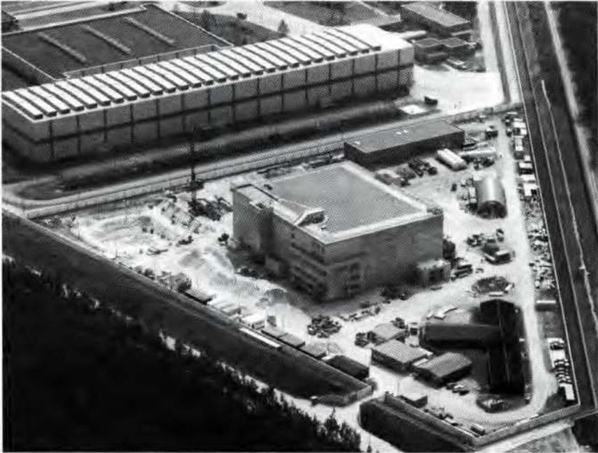
Auf dem Betriebsgelände des Brennelementzwischenlagers Gorleben wird derzeit eine Pilot-Konditionierungsanlage errichtet (Halle im Vordergrund). Dort sollen u.a. abgebrannte Brennstäbe für die Endlagerung konditioniert werden. (Foto: BLG)
