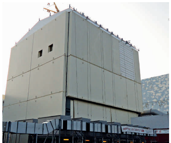
Abb. 6.18: Phasen der Errichtung der Einhausung um das Reaktorgebäude von Block 1 (Quelle: TEPCO).
