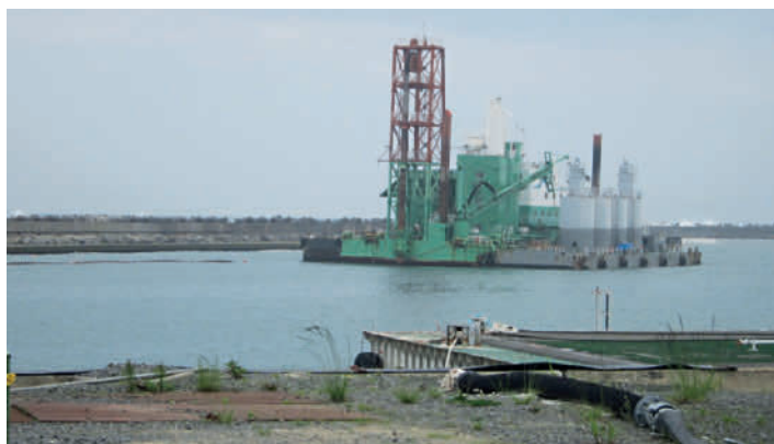
Abb. 6.16: Schwimmendes Arbeitsgerät zur Versiegelung des Meeresbodens (Quelle: TEPCO).
