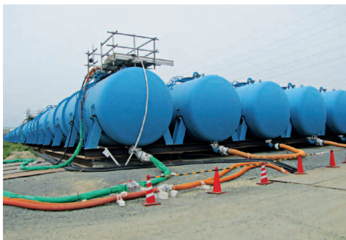
Abb. 6.11: Behälter zur Lagerung von kontaminiertem Wasser, links mit 100 m 3 , rechts verschraubte Tanks mit 1.000 m 3 Volumen (Quelle: TEPCO).
