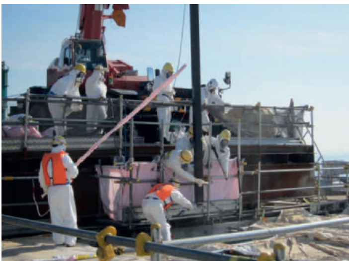
Abb. 6.21: Probeweise Bergung eines unbestrahlten Brennelements aus dem BE-Lagerbecken von Block 4 im Juli 2012 (Quelle: TEPCO).
