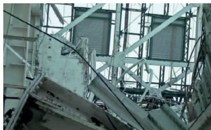
Abb. 6.25: Bildaufnahmen aus dem Einsatz eines Erkundungsballons im Oktober 2012: Blick durch den Bedienflur von Block 1 (Quelle: TEPCO).
