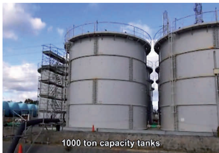
Abb. 6.11: Behälter zur Lagerung von kontaminiertem Wasser, links mit 100 m 3 , rechts verschraubte Tanks mit 1.000 m 3 Volumen (Quelle: TEPCO).
