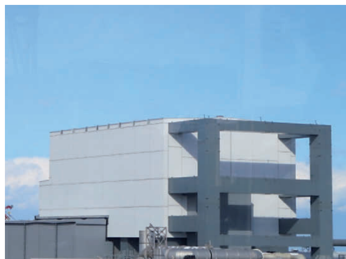
Abb. 6.20: Einhausung des Blocks 4 (Quelle: TEPCO).
