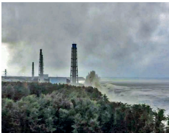
Abb. 3.2: Von einer Überwachungskamera aufgenommenes Bild einer Tsunami-Welle (Bildmitte, rechts neben dem Abgaskamin), die sich beim Auftreffen auf den Standort aufbaut. Zwischen den beiden Abgaskaminen ist der obere Teil des Reaktorgebäudes von Block 4 mit einer Höhe von über 40 Metern erkennbar (Quelle: TEPCO).
