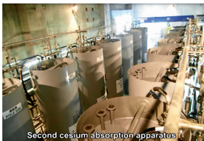
Abb. 6.7: Blick in die Wasseraufbereitungsanlage (Quelle: TEPCO).
