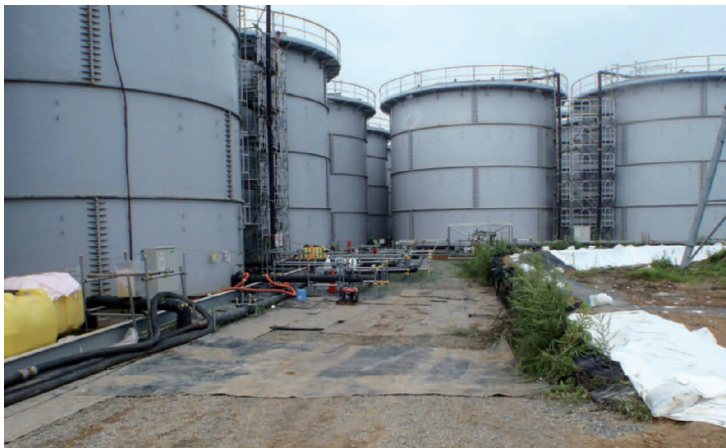
Abb. 3.35: Tanks des Aufstellungsbereichs H4, in dem sich die mit INES 3 eingestufte Leckage ereignete. Rechts im Bild ist ein aus Sandsäcken errichteter Wall zu erkennen, mit dem im Fall weiterer Leckagen eine weitere Verbreitung des kontaminierten Wassers verhindert werden soll (Quelle: TEPCO).
