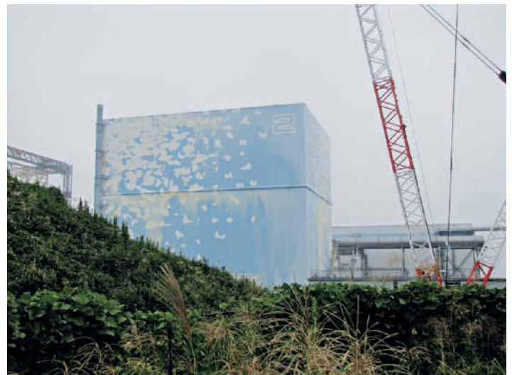
Abb. 3.19: Das praktisch unbeschädigte Reaktorgebäude 2 (Quelle: TEPCO).
