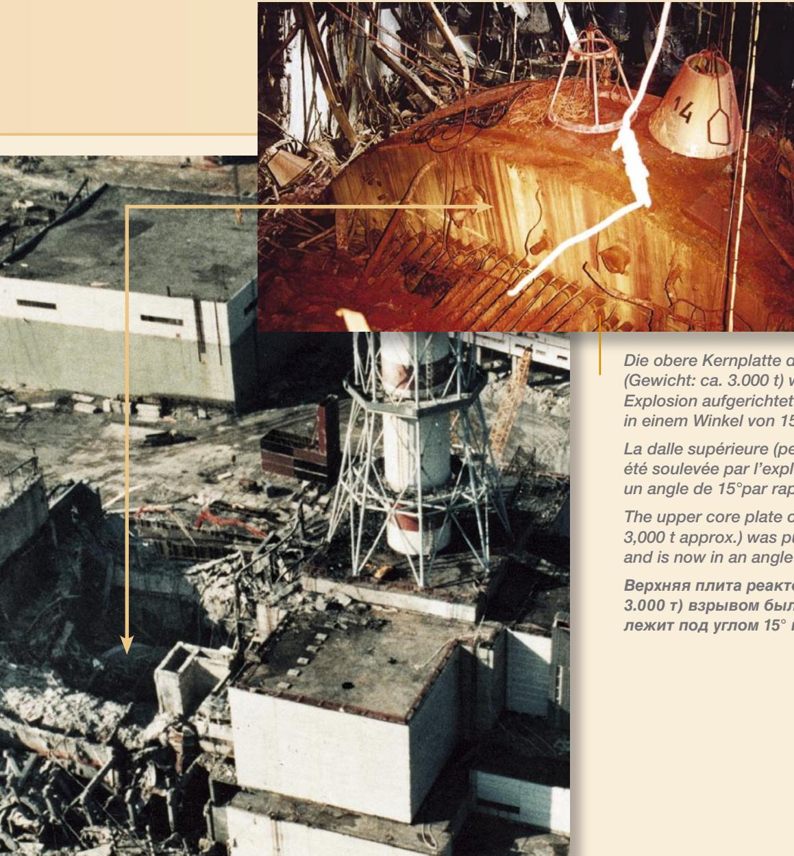
*Die obere Kernplatte des Reaktors (Gewicht: ca. 3.000 t) wurde durch die Explosion aufgerichtet und steht nunmehr in einem Winkel von 15° zur Senkrechten.*
