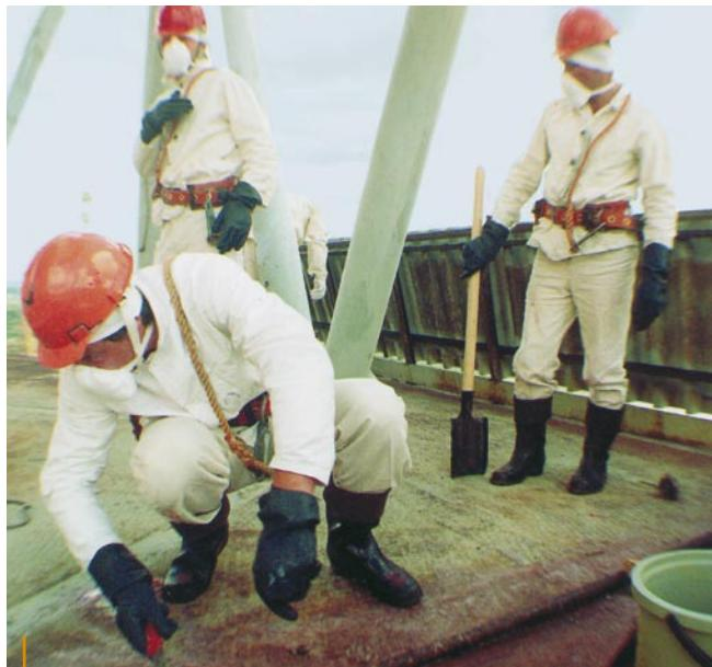
Dekontaminationsmaßnahmen auf dem Dach des Sarkophags
