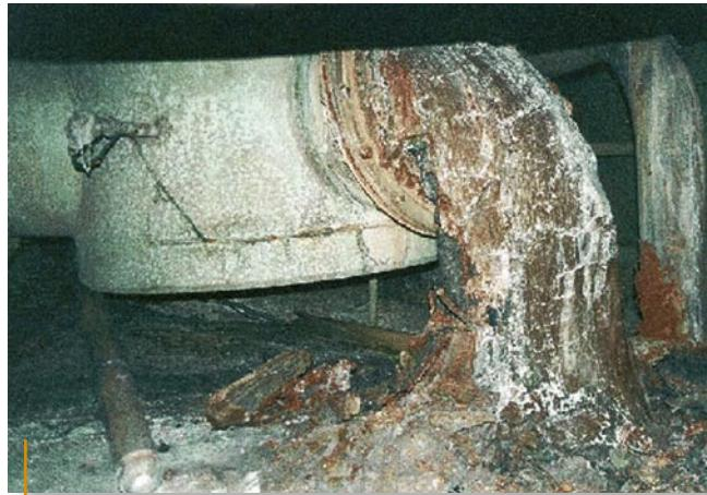
Nach dem Unfall sind mindestens 150 t Kernbrennstoff im Reaktorgebäude verblieben und befinden sich z. B. in Form von erstarrter Brennstofflava in Rohrleitungen.
