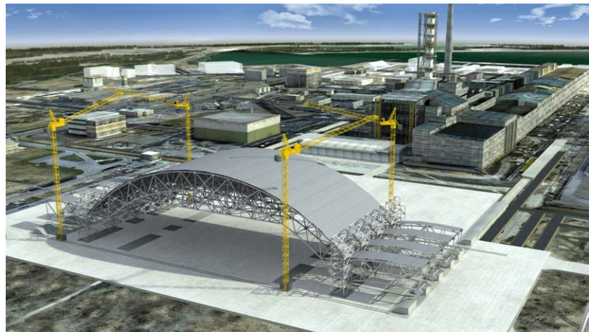
Bau des New Safe Confinement (Abbildung: EBRD/Novarka)
