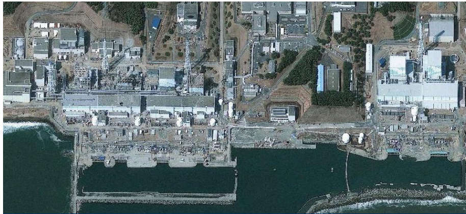
Luftaufnahme des Standorts Fukushima Daiichi nach dem Unfall (Foto: Tepco)
