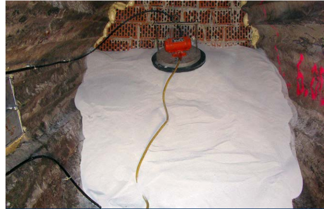
Bauphase: Einbau und Verdichten von Magnesiumsulfat In-situ (Foto: GRS)
