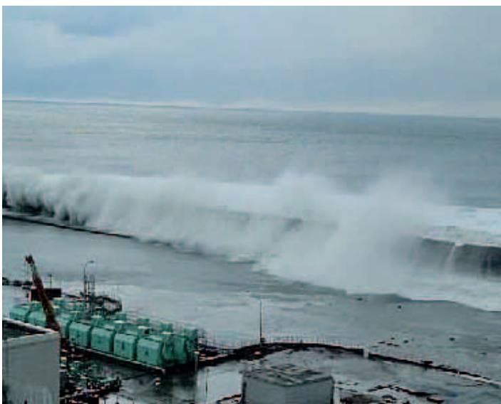
Abb. 3.12: Überflutung des seeseitigen Teils des Anlagengeländes durch erste Tsunamiwellen, aufgenommen von einer Überwachungskamera (Quelle: TEPCO).
