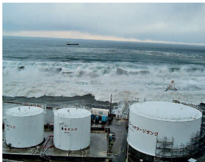
Abb. 3.3: Beginn der Überflutung des Anlagengeländes, aufgenommen von einer Überwachungskamera. Aus späteren Luft- und Satellitenaufnahmen wurde ersichtlich, dass einige Tanks von der Art der hier gezeigten durch den Tsunami zerstört bzw. von ihrem ursprünglichen Standort weggerissen und landeinwärts getragen wurden (Quelle: TEPCO).
