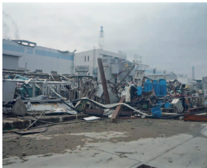
Abb. 3.13: Blick auf das Turbinenhaus von Block 3 (links im Hintergrund) nach dem Tsunami (Quelle: TEPCO).
