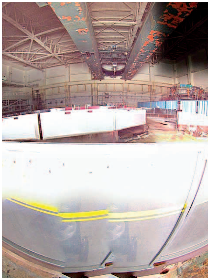
Abb. 3.23: Blick auf die fünfte Ebene von Reaktorgebäude 2 mit dem an der Dachkonstruktion verankerten Gebäudekran (aufgenommen am 20. Oktober 2011) (Quelle: Tepco).
