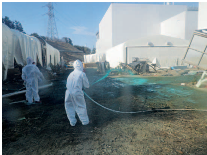
Abb. 6.6: Versprühen von Bindemittel auf dem Anlagengelände (Quelle: TEPCO).
