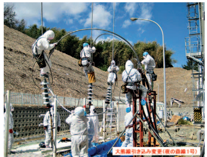
Abb. 6.2: Arbeiten zur Wiederherstellung der Anbindung der Anlage an das Stromnetz (Quelle: TEPCO).
