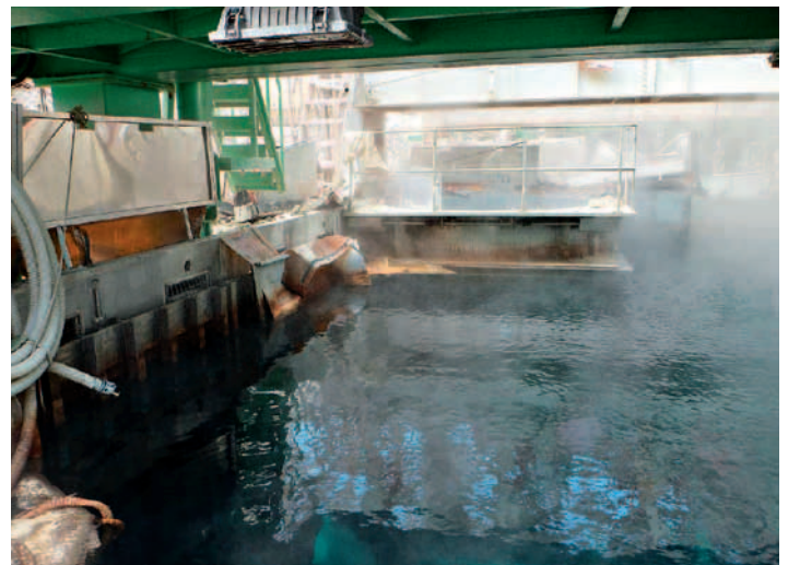
Abb. 3.32: Blick auf das Brennelementlagerbecken von Block 4 (aufgenommen am 29. Juni 2011) (Quelle: Tepco).
