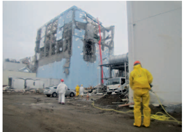
Abb. 3.30: Wassereinspeisung in Block 4 mithilfe einer Autobetonpumpe (Quelle: Tepco).
