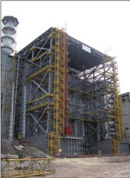
Abb. 3: Stabilisierungsmaßnahmen an der Westwand des Sarkophags
