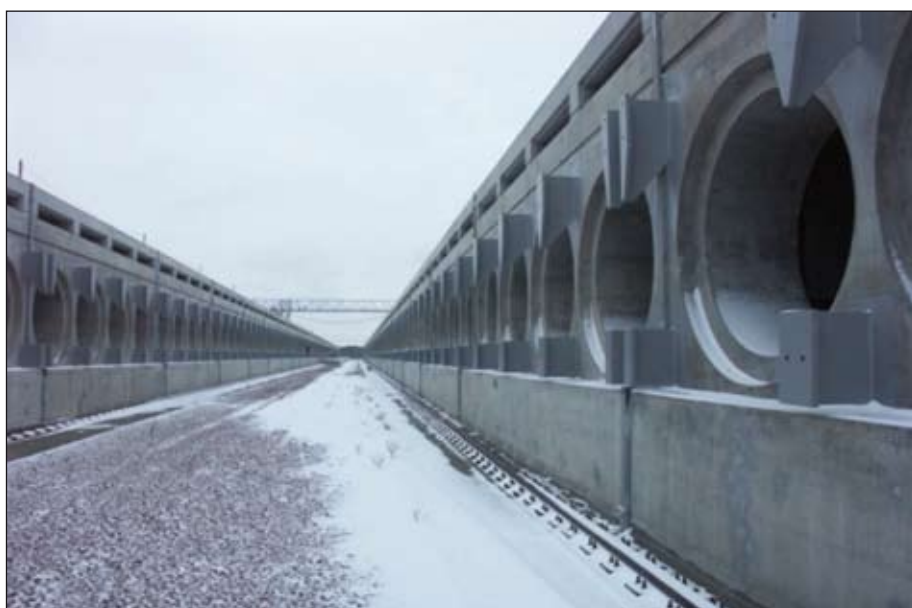
Abb. 9: Lagermodule des Zwischenlagers ISF-2
