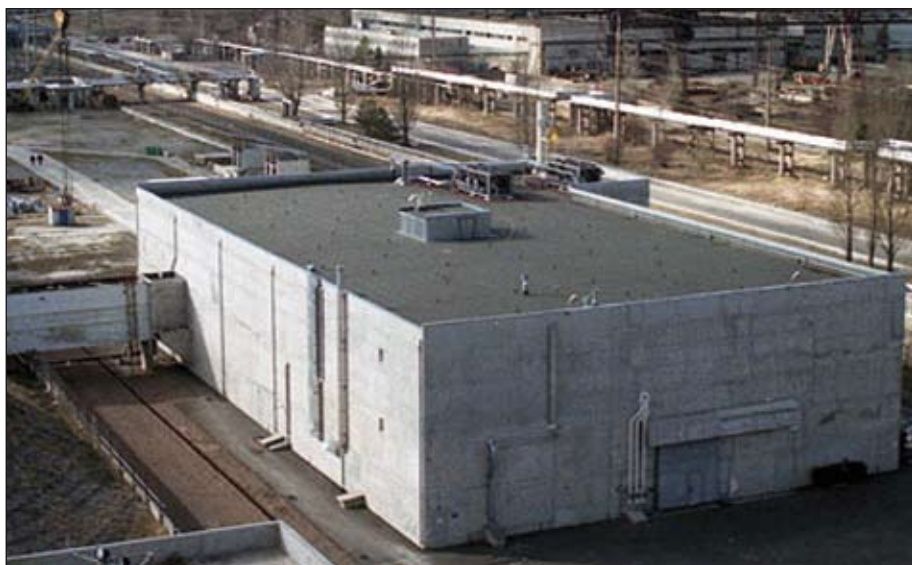
Abb. 7: Behandlungsanlage für flüssige schwach- und mittelaktive Abfälle LRTP
