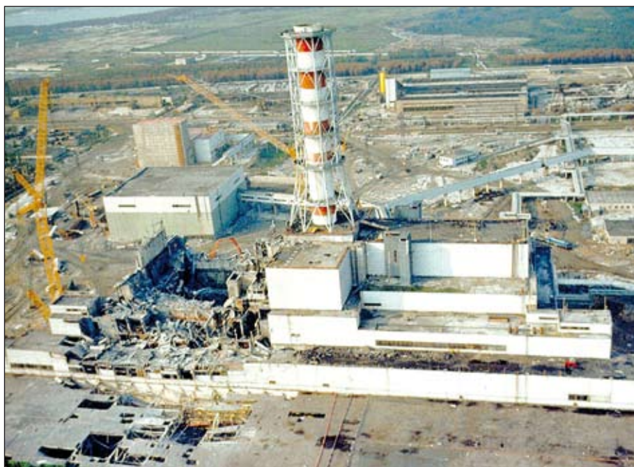
Abb. 5: Der zerstörte Block 4 (links) und Block 3 (rechts) des Kernkraftwerks Tschernobyl
