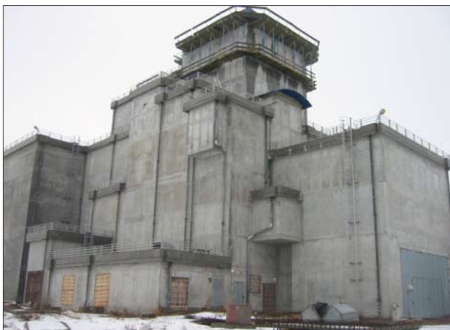
Abb. 8: Prozess- und Konditionierungsgebäude des Zwischenlagers ISF-2
