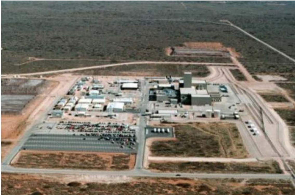
Abb. 9 Luftbild der WIPP-Tagesanlagen /POW 07/
