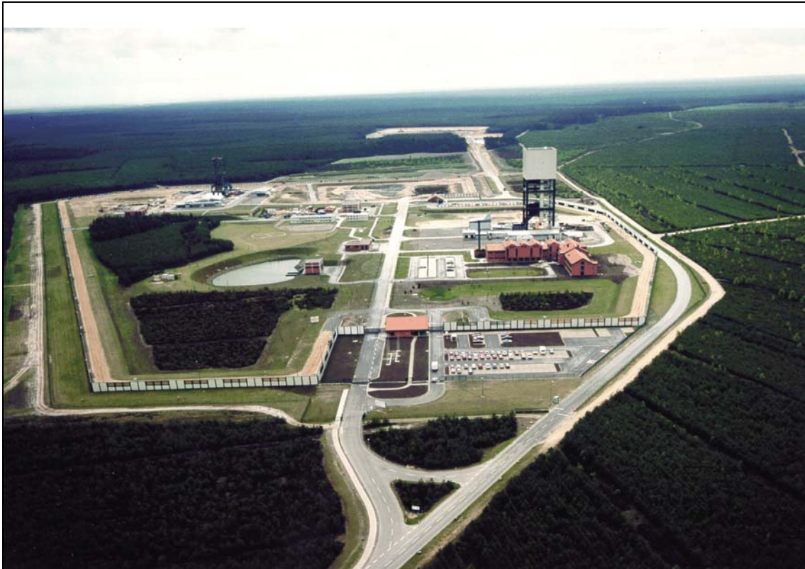
Abb. 12 Tagesanlagen des Erkundungsbergwerks Gorleben
