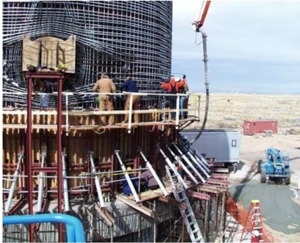
**Abb. 4.11** Blick auf die Hüllrohre der Spannkabel im Bereich der Materialschleuse während der Bauphase (nach /HES 03/)
