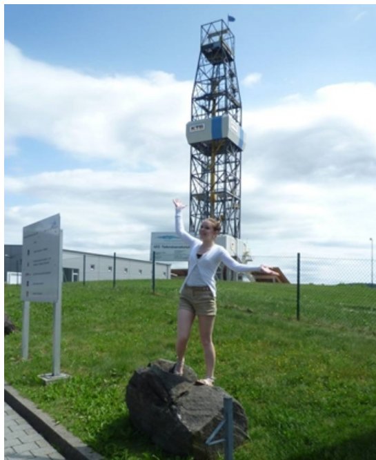
Abb. 4.13 Bohrturm der KTB Hauptbohrung in Windischeschenbach
