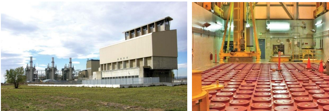
Abb. 1.18 MVDS-Trockenlager für bestrahlte Brennelemente in Fort St. Vrain: Außenansicht der Anlage (linkes Bild) und Lagerhalle mit Lagerzellen (rechtes Bild) (Quelle: Fort St. Vrain Independent Spent Fuel Facility, /FSV 12/)
