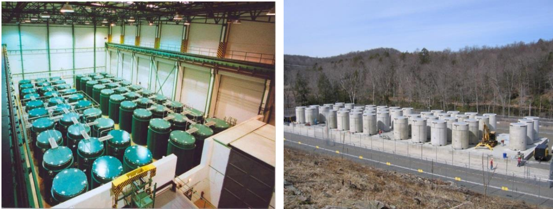
Abb. 1.15 Lagerhalle mit CASTOR-Behältern im ISFSF Dukovany (linkes Bild) /NRC 14/ und Lagerbehälter in der Connecticut Yankee Independent Spent Fuel Storage Installation (rechtes Bild) (Quelle: Connecticut Yankee Kernkraftwerk, /COY 15/)
