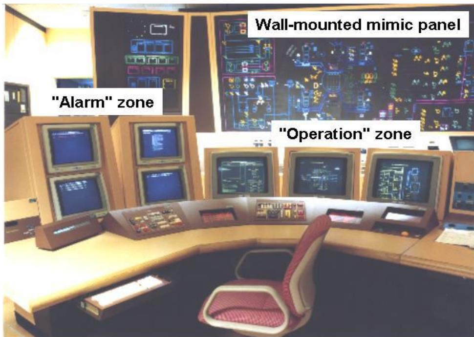
**Abb. 2-6** Arbeitsplatz des Operateurs im N4-Kernkraftwerk
