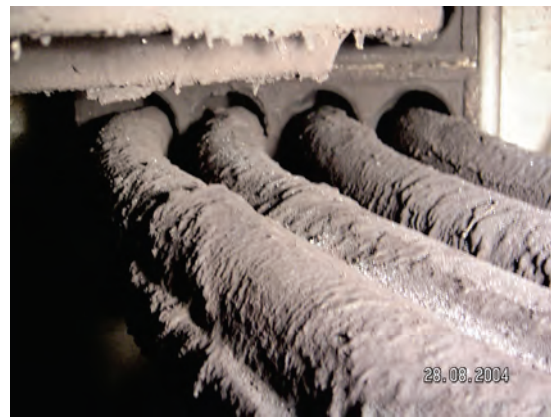
Abb. 3-3: Links: Kabelkanal nach Entfernung der Kabel; Rechts: beschädigte Kabeltrasse
