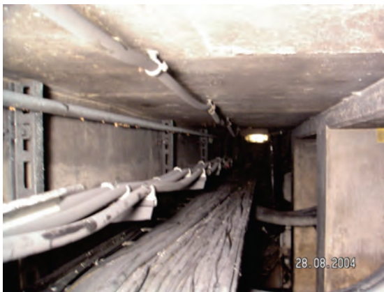
Abb. 3-3: Links: Kabelkanal nach Entfernung der Kabel; Rechts: beschädigte Kabeltrasse
