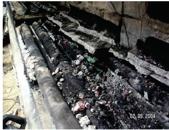
Abb. 3-3: Links: Kabelkanal nach Entfernung der Kabel; Rechts: beschädigte Kabeltrasse
