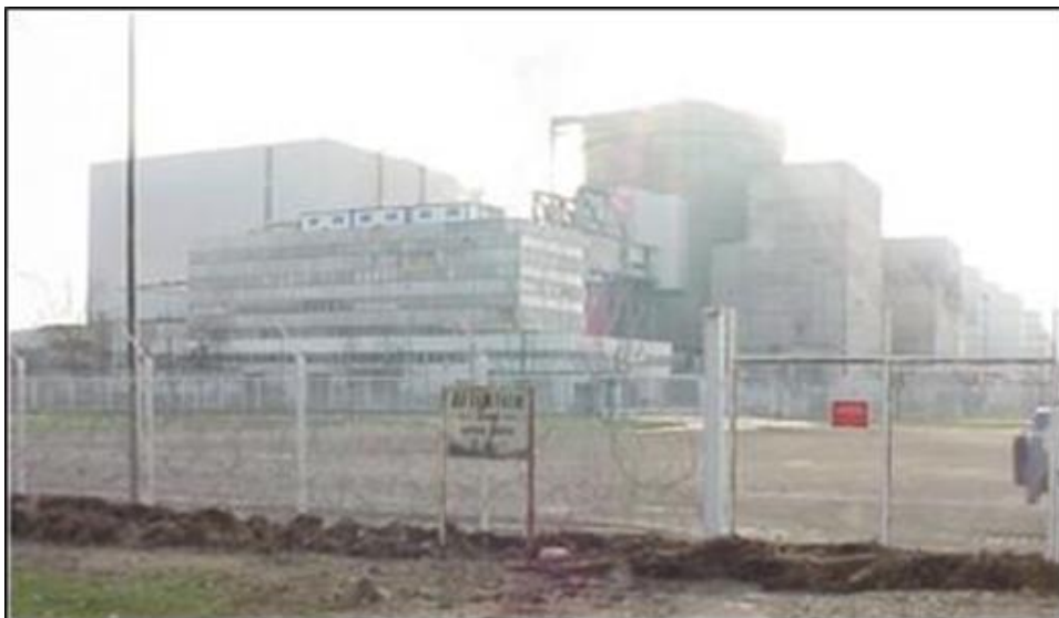
Abb. 4-2: Treibgutrückstände zeigen den Wasserstand am Zaun des Kernkraftwerkes Le Blayais /RIS 10/
