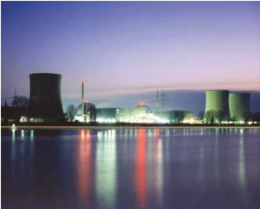
Das Kernkraftwerk Biblis mit den Blöcken A und B, die seit 1975 bzw. 1977 in Betrieb sind, gehört zu den ältesten kommerziellen Kernkraftwerken Europas
