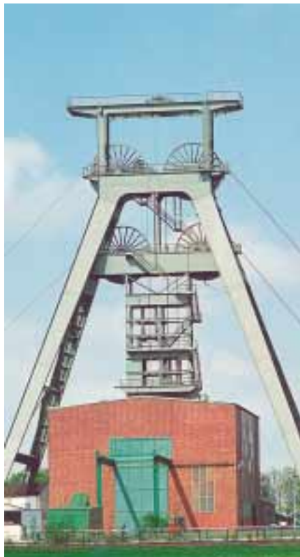
Die Schachtanlage Konrad ist für die Endlagerung radioaktiver Abfälle mit vernachlässigbarer Wärmeentwicklung vorgesehen
